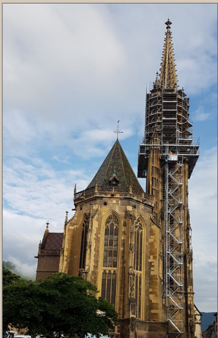
Mise en place de l'échafaudage
