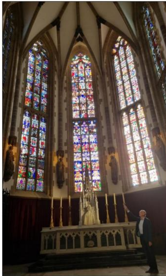
Édouard Heinrich président de la Fondation pour la sauvegarde de la collégiale, montre les vitraux qui seront concernés par le diagnostic. Photos L'Alsace/I.B.
